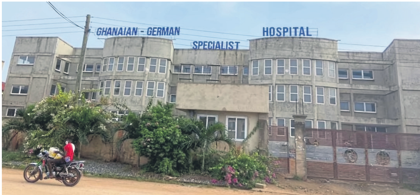
Der Klinikbau steht, der Innenausbau ist fast fertig. Um das Gelände kümmern sie die Helfer als Nächstes.
